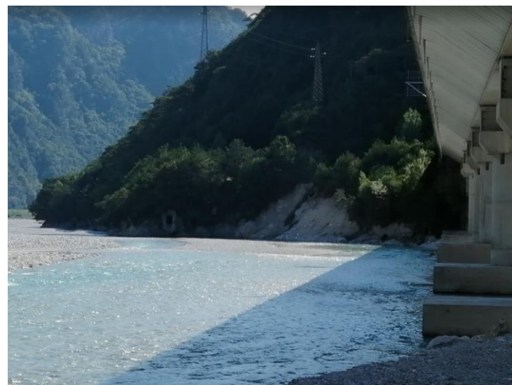
Foto 12: Erosione della sponda destra del Fiume Fella in prossimità del pilone n.1 dx – Visuale da NE.
