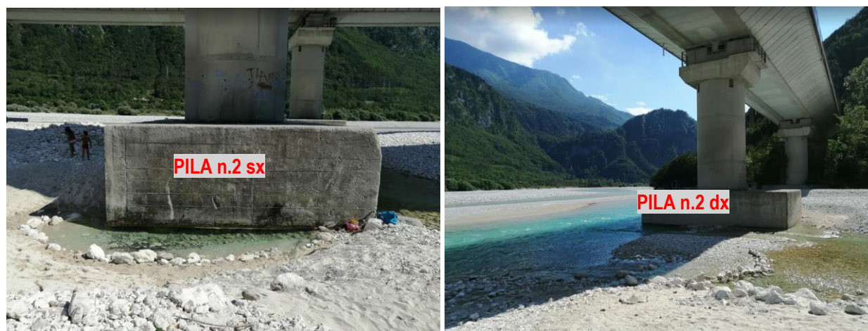
Figura 6. Illustrazione della seconda coppia di pile, partendo dalla galleria ad ovest. Si nota come esse siano interamente collocate lungo il flusso del Rio Glagnò.
