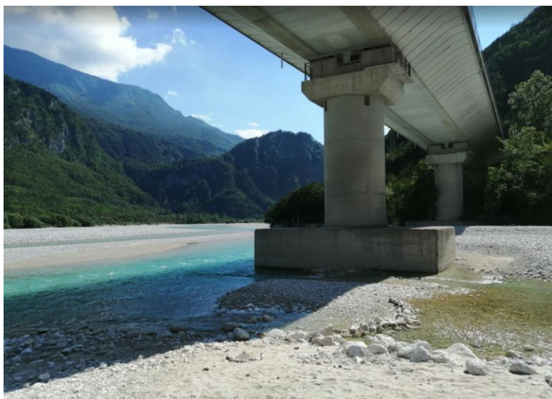
Foto 7: Erosione al piede del pilone n.2 dx.
